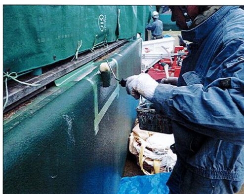
H28年度 庭球場緩衝フェンス修繕
