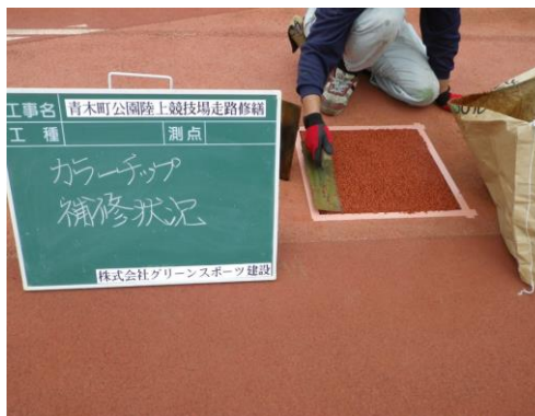
H26年度 陸上競技場走路等修繕
