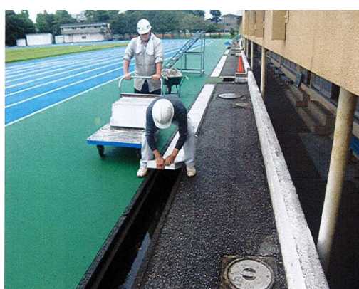
H29年度 陸上競技場側溝蓋修繕
