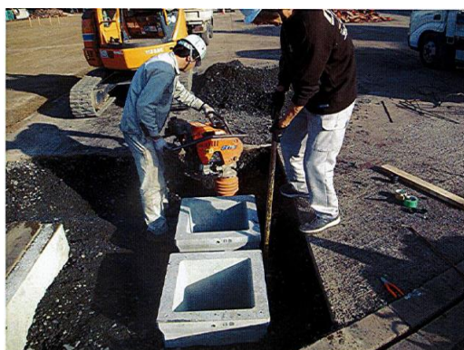
H28年度 陸上競技場配管修繕
