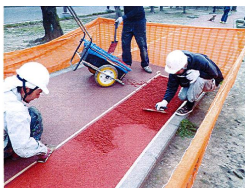
H27年度 ジョギングコース舗装部分修繕
