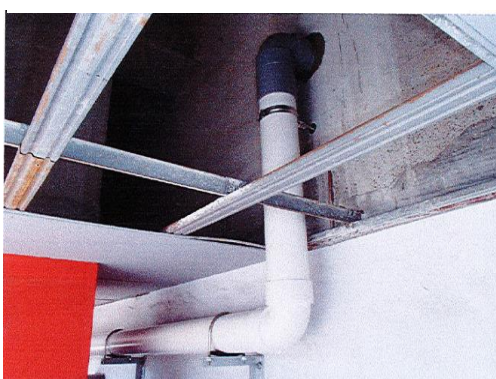
H27年度 武道センター2階便所污水排水管修繕
