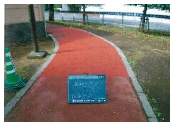
R 4 ジョギングコース路面補修 （弓道場脇）
