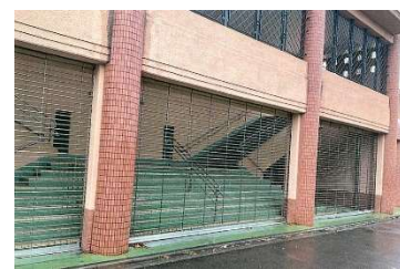
R 4 プール棟シャッター修繕
